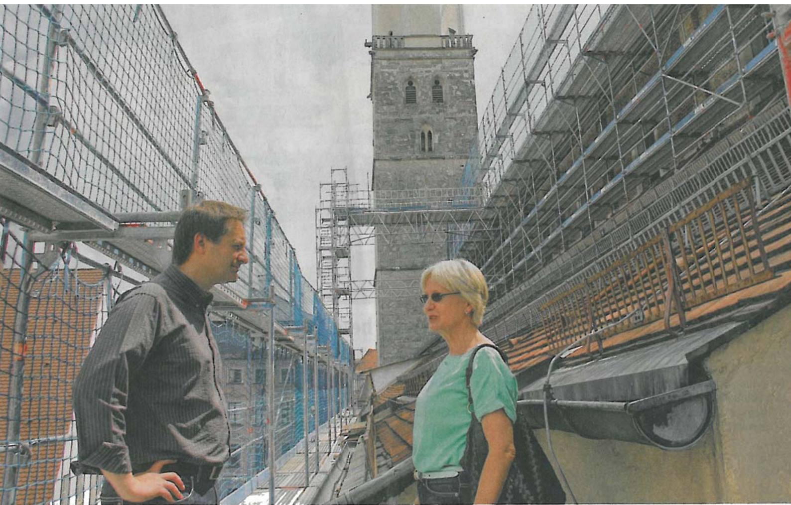
Memminger Stadtzentrum startet ein großes Bauvorhaben: die Sanierung der evangelischen Martinskirche. Unser Bild zeigt Pfarrer Ralf Matthes und Architektin Ingrid Stetter bei einem Rundgang auf der Baustelle.
