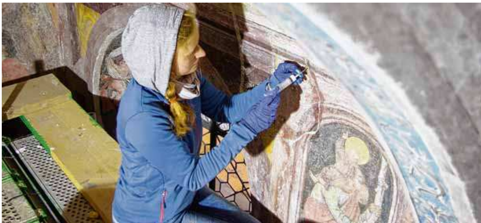
Bei der Sanierung der Martinskirche ist Restauratorin Laura Kalfels derzeit in der Zangmeisterkapelle beschäftigt: Mit einer Spritze injiziert sie kalkhaltiges Material in einen Hohlraum, um so zu verhindern, dass die Putzschicht abplatzt und die jahrhundertealten Malereien zerstört werden.
